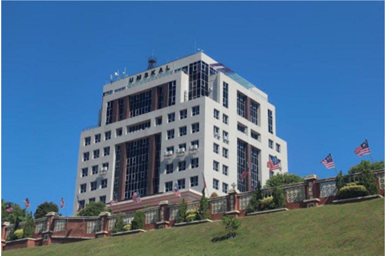
Universiti Malaysia Sabah Kampus Antarabangsa Labuan (UMSKAL). - Foto Ihsan UMSKAL
