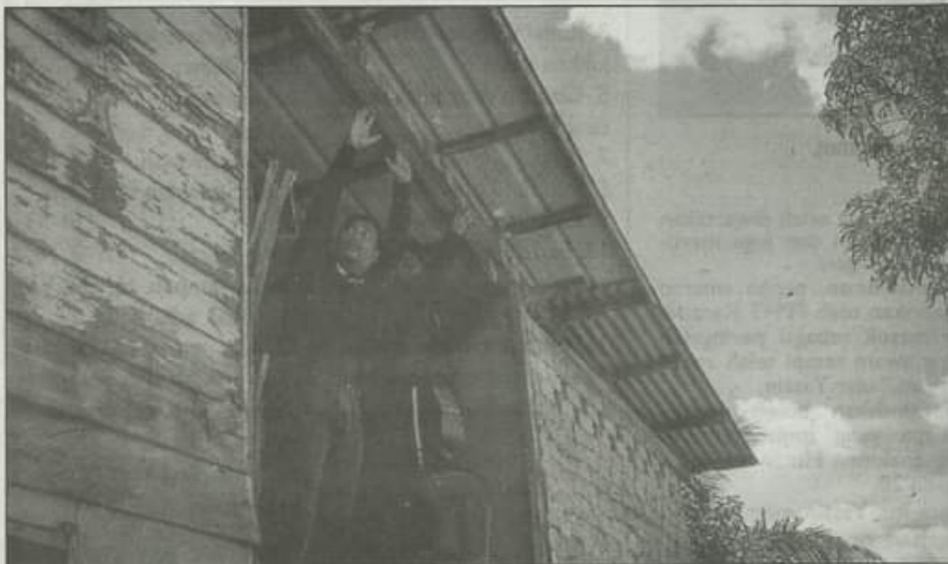
DIBAIK PULIH... Struktur dinding di bahagian dapur sedang dibaik pulih.
