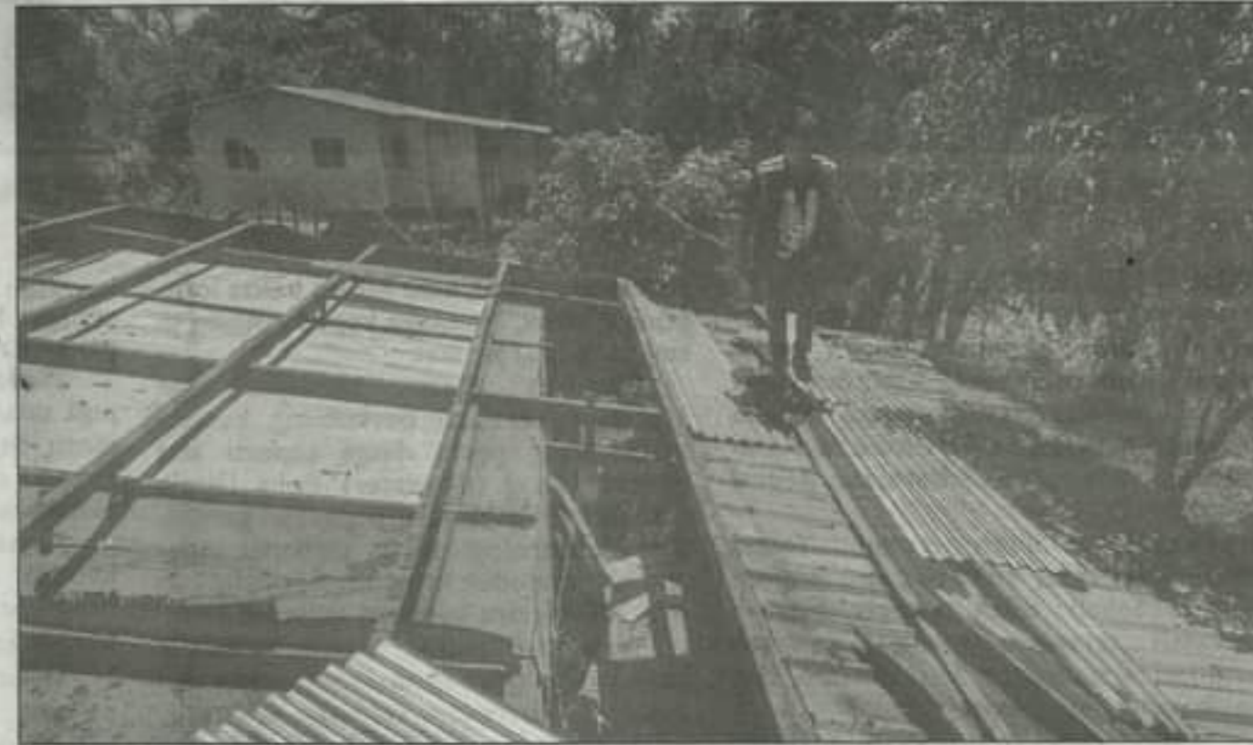
DIGANTI BARU... Bumbung yang sudah reput dan usang dibuang untuk digantikan dengan yang baru.
