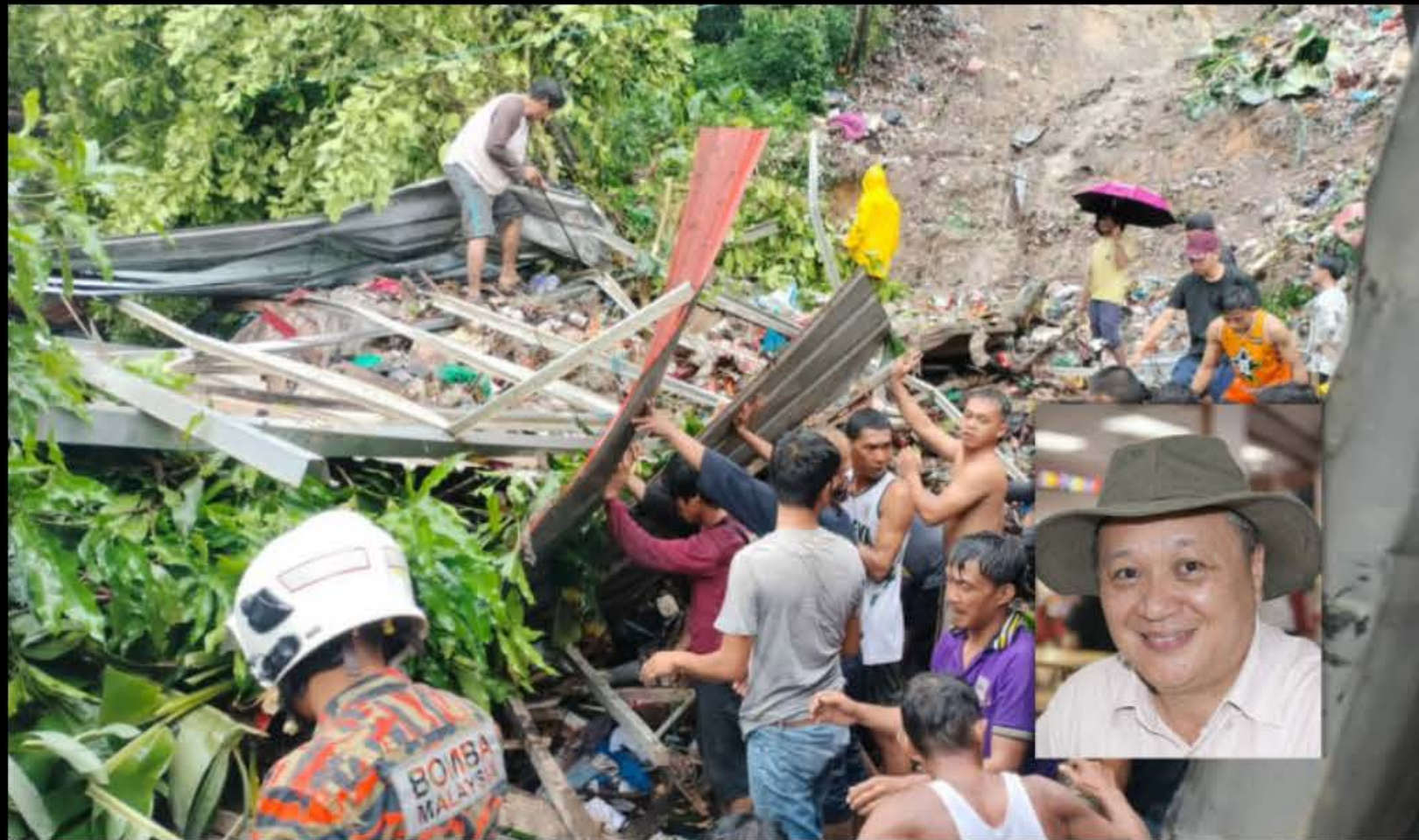
Kesan tanah runtuh di Kampung Cenderakasih, Kolombong, pada September 2025 yang menimbus sebuah rumah dan mengorbankan tujuh sekeluarga termasuk empat kanak-kanak.
