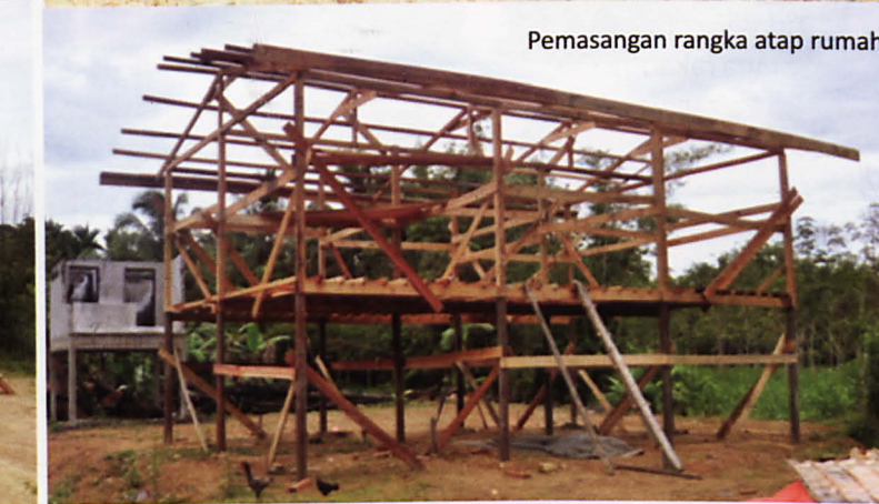
Pemasangan rangka rumah pertama
