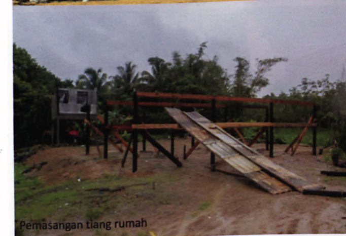
Pemasangan rangka rumah pertama
