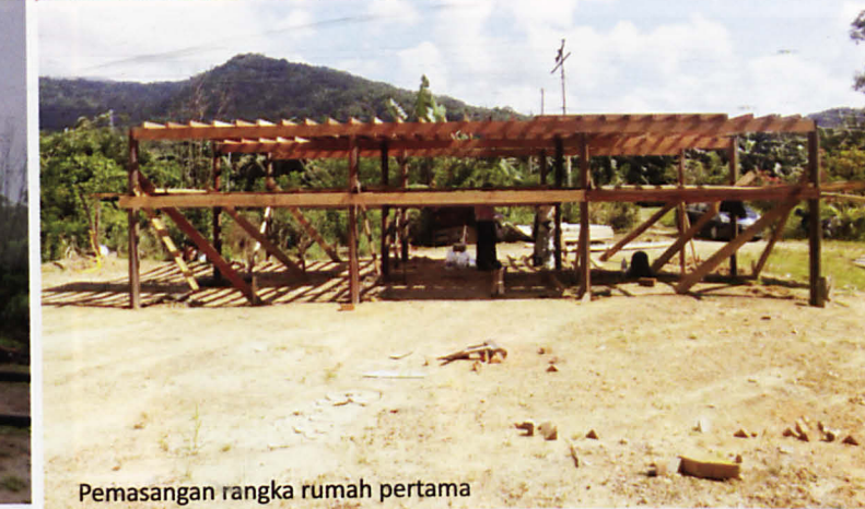
Pemasangan rangka atap rumah
