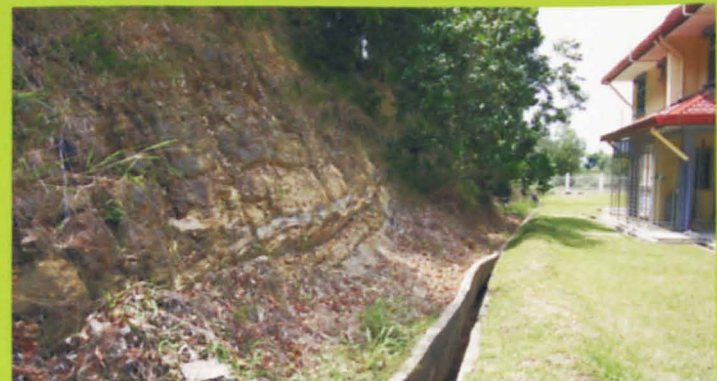
Arah kemiringan lapisan batuan dan cerun potongan batuan (1H:3V) yang saling bertentangan.
